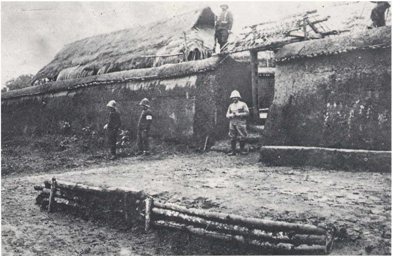
Le repaire de Cho Go (photo du lieutenant Romain-Desfossés).
